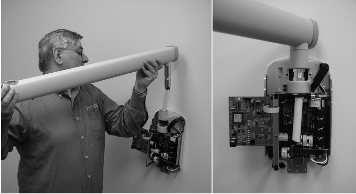
صورة ١٨ تركيب الذراع الأفقية
