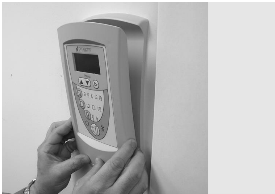
صورة ٣٨ تثبيت لوحة التشغيل إلى حامل التثبيت
